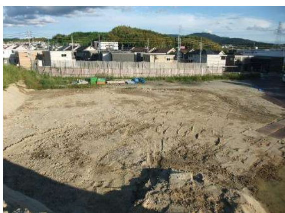
2 段目北側法面（竹藪）
